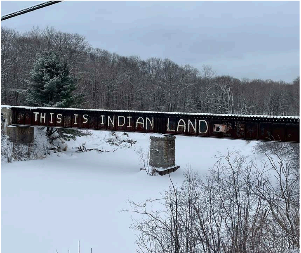
Pont de la Première Nation de Ketegaunseebee Garden River peint à l'automne 1973 par les « six premiers » : Bob, Darrell, Keith et Willie Boissoneau, et Andre et Scott Lesage, photo prise le 28 février 2023 (Bureau de l'interlocutrice spéciale indépendante).
