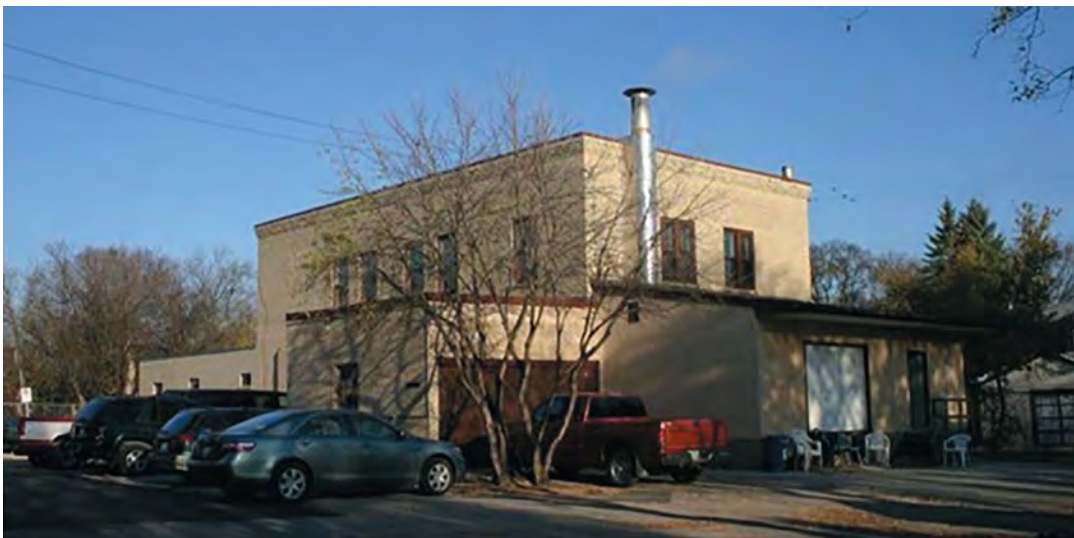
Figure 2.11. Photographie montrant la centrale électrique et le bâtiment de la buanderie dans le complexe Good Shepherd Marymount (Ville de Winnipeg, Murray Peterson, Rapport sur le patrimoine : 442, rue Scotia, complexe scolaire Marymount, décembre 2011, https://legacy.winnipeg.ca/ppd/Documents/Heritage/HeritageResourcesReports/Scotia-442-long.pdf ).
