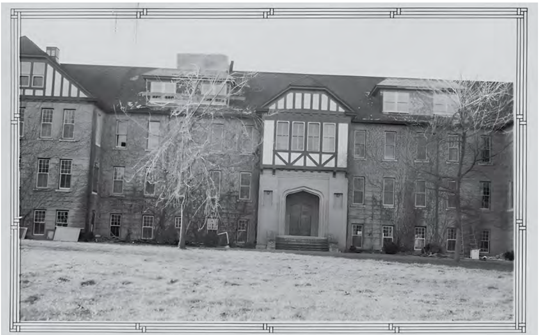
Figure 3.12. Hôpital indien de Coqualeetza, façade avant montrant de nouvelles lucarnes, Sardis, Colombie-Britannique, 11 janvier 1941 (dossier e011080334, ministère des Affaires indiennes et du Nord canadien, BAC).
