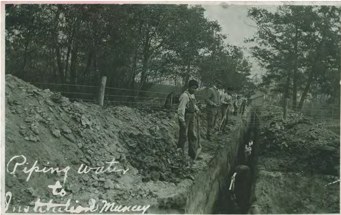
Figure 3.4. Des enfants creusent des tranchées pour des conduites d'eau à l'Institut industriel du mont Elgin, Muncy [pensionnat indien du mont Elgin], s.d. [vers 1909] (article 1990.162P/1169, archives de l'Église unie du Canada).
